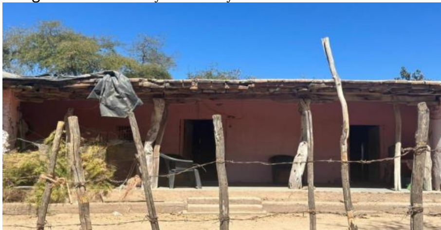
Fotografía 20. Vivienda yoreme mayo construida de adobe con techo de terrado.
