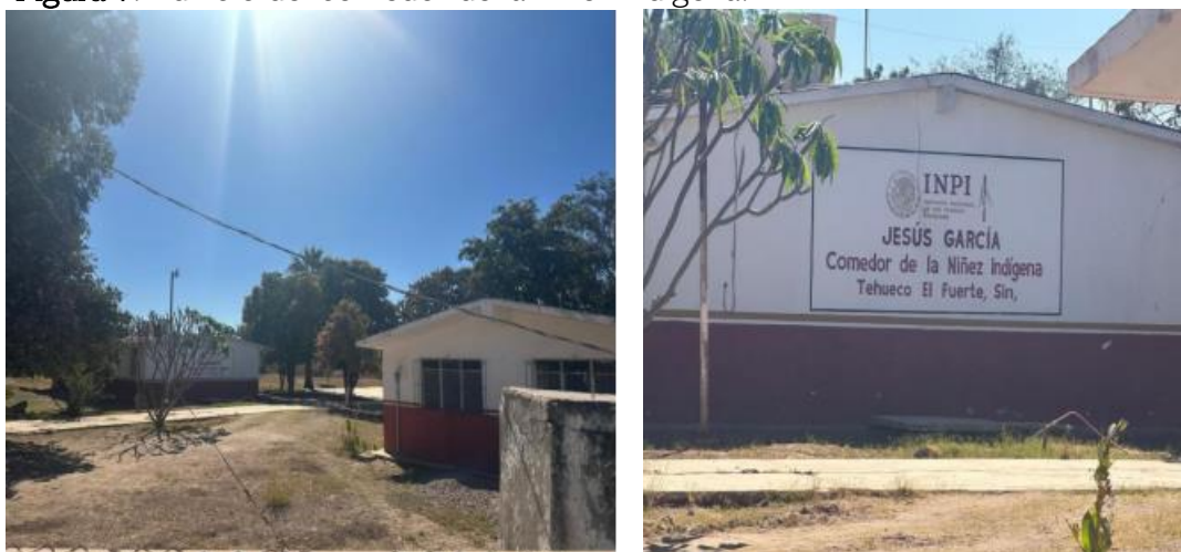
Figura 7. Edificio del comedor de la niñez indígena.
